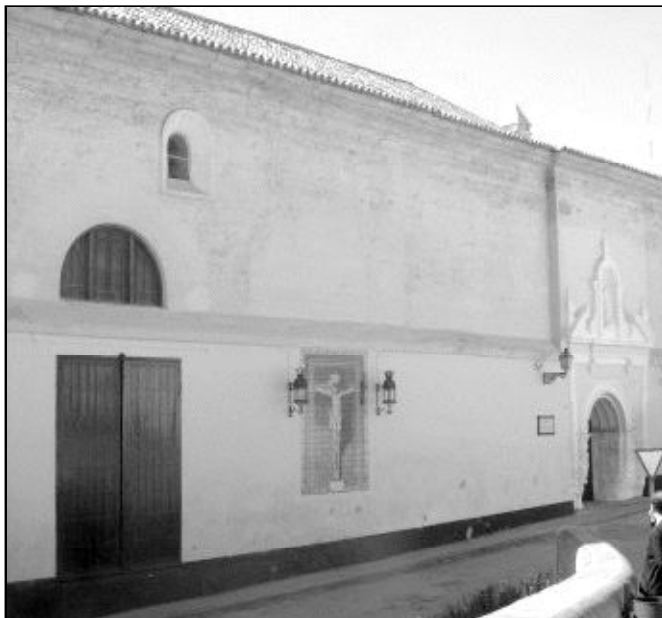
Fachada de la Iglesia de San Juan en Antequera
