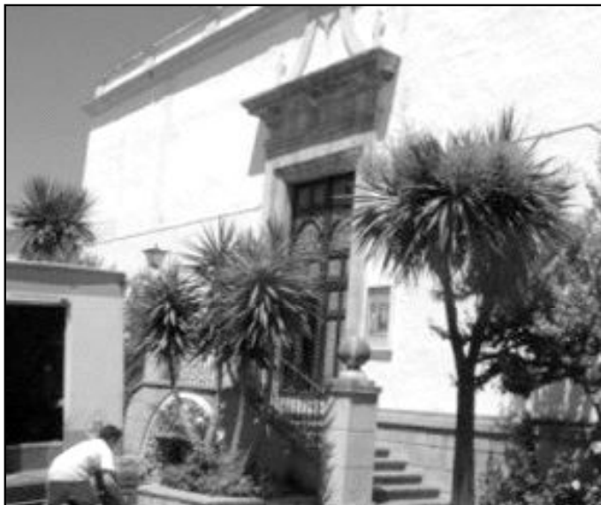
Fachada de la Iglesia parroquial de Cortes de la Frontera
