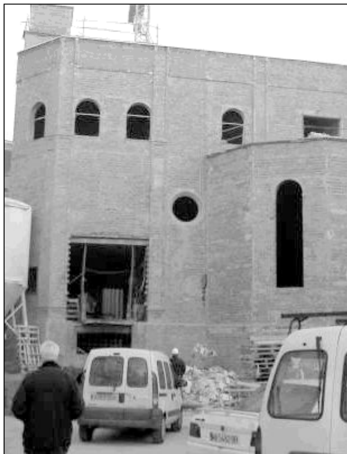
Obras de la parroquia de El Morche, a finales de 2005
