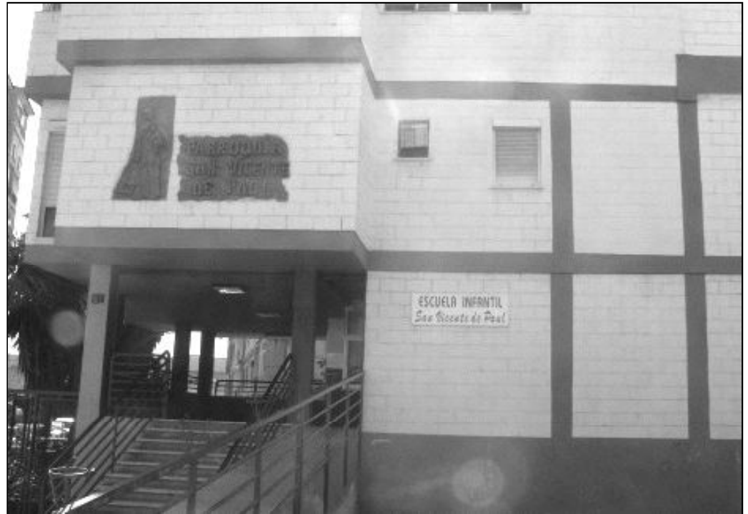
Fachada de la parroquia de San Vicente de Paúl, en calle La Unión
